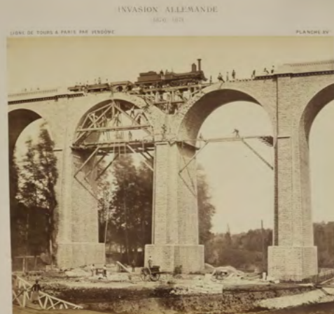
VIADUC DE VILLEDÔMER
